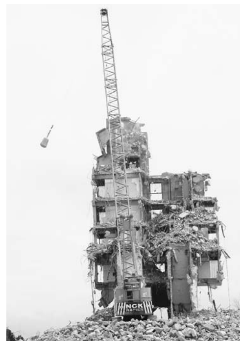
▲ FIGURA 3.10 Energía cinética y trabajo Un objeto en movimiento, como esta bola para demolición de construcciones, procesa energía cinética y, por lo tanto, puede efectuar trabajo.
