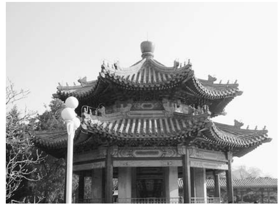
▲ FIGURA 9.19 Aspectos de diseño solar pasivo en la China antigua a) En verano, cuando el ángulo del Sol es grande, los aleros dan sombra a la construcción. Los ladrillos y las paredes de la casa son gruesos para reducir el flujo de calor por conducción al interior. En invierno, el ángulo del Sol es bajo, por lo que los rayos solares entran a la vivienda, en especial con la ayuda de los aleros curvos y ascendentes. Las hojas de los árboles caducifolios cercanos ofrecen sombra adicional en verano, pero permiten la entrada de luz solar cuando han perdido sus hojas en invierno. b) Imagen de una construcción como la descrita, en Beijing, China, en diciembre.
